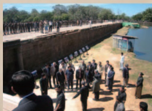
アンコール・ワット西参道 修復第Ⅰ工区完成（2007年）
